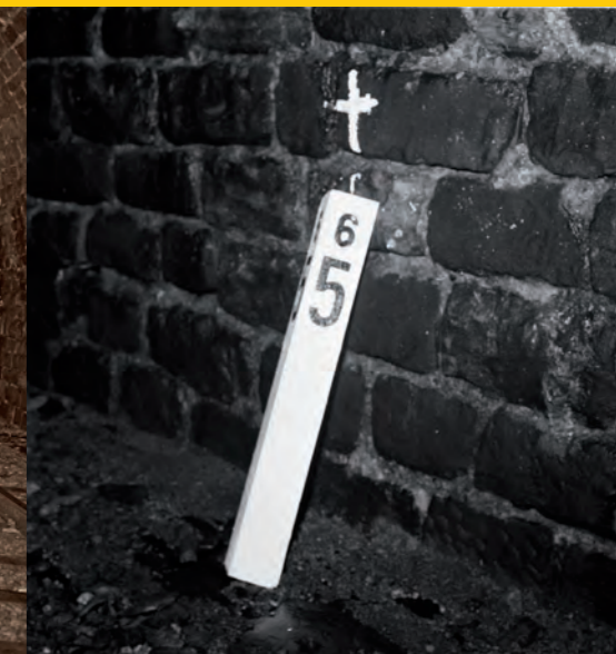
Weißgestrichene Kanteisen dienten damals den Lokführern auch innerhalb des Tunnels als „Meilensteine“.
