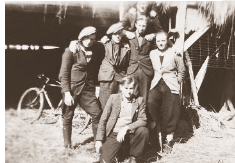
21.04.1944, Morgens, nach einer Scheunenübernachtung Après avoir passé la nuit dans une grange
